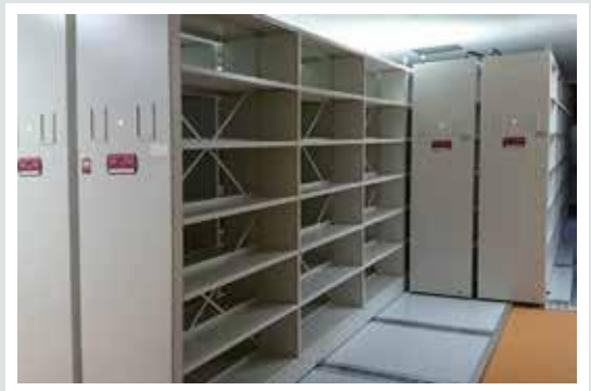
стелажі з електроприводом в архіві
